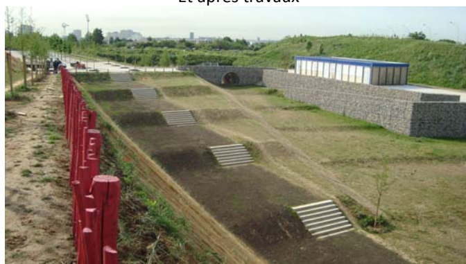
Et après travaux
